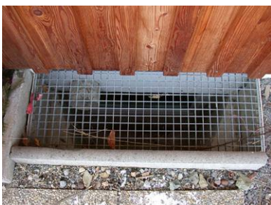
Abbildung 10: Fortluft darf nicht in die Hinterlüftung gelangen
