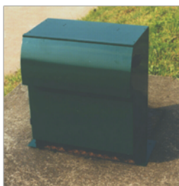
Abbildung 2: Außenluftansaugung mit Taschenfilter (Quelle: Fa. Drexl und Weiss)
